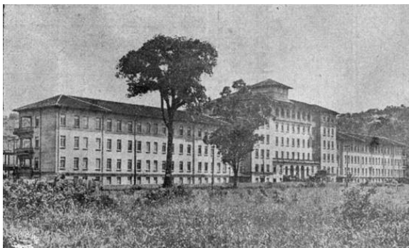
FIGURA 3 – SANTA CASA DE MISERICÓRDIA DE SANTOS – 1543
