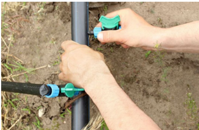
FIGURA 20 – INSERÇÃO DE ACESSÓRIO EM UM CANO DE ÁGUA PARA SISTEMA DE IRRIGAÇÃO POR GOTEJAMENTO
