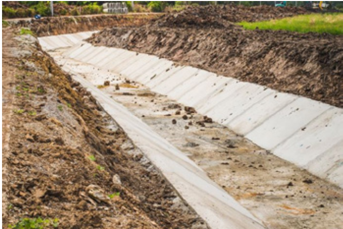
FIGURA 25 – CONSTRUÇÃO DE DRENOS PARA EVITAR INUNDAÇÕES
