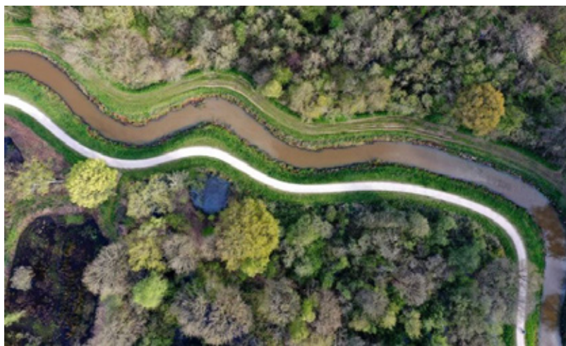
FIGURA 27 – VISTA SUPERIOR DE UM CANAL DO TIPO NATURAL
