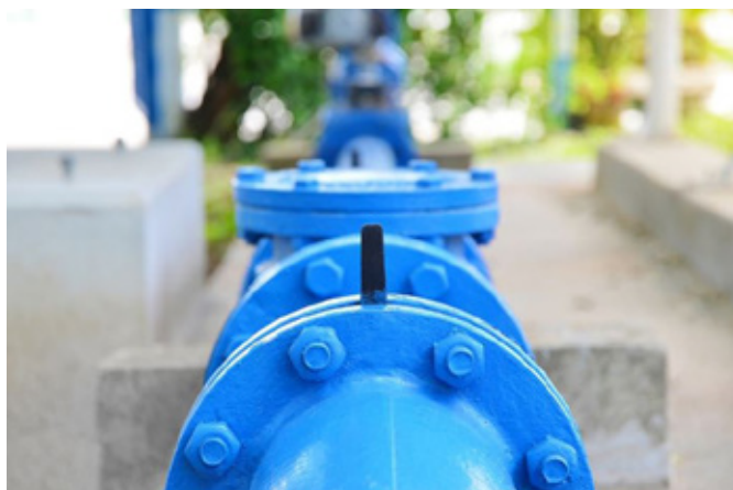
FIGURA 4 – TUBO DE AÇO (MONTAGEM DE TUBULAÇÃO DE FLANGE)
