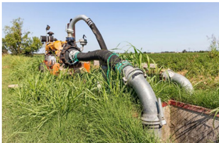
FIGURA 18 – SISTEMA BOMBA DE ÁGUA PARA IRRIGAÇÃO AGRÍCOLA DE FORMA AUTOMÁTICA
