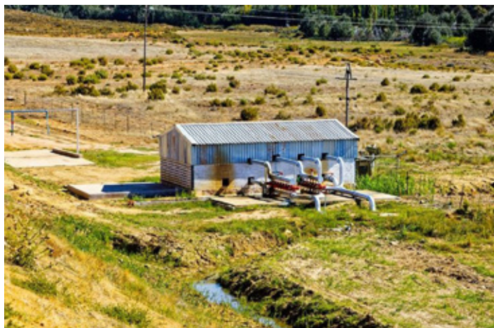
FIGURA 19 – EDIFICAÇÃO DE UMA CASA DE BOMBAS PARA SISTEMAS DE IRRIGAÇÃO
