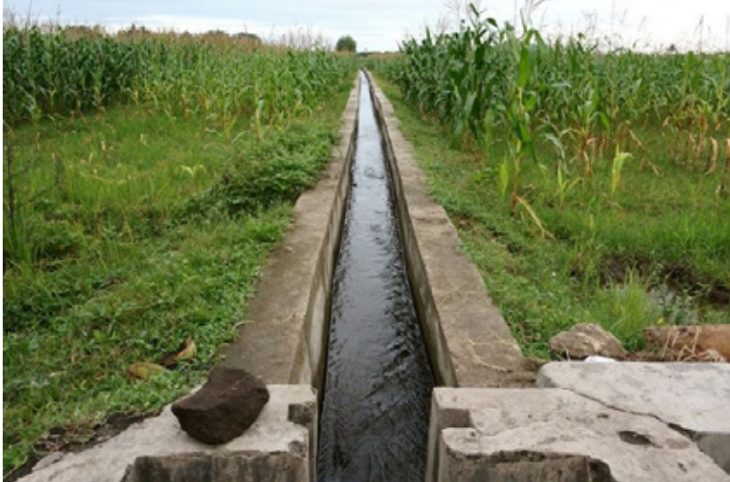
FIGURA 6 – CANAL DE IRRIGAÇÃO AGRÍCOLA USADO PARA DRENAR ÁGUA
