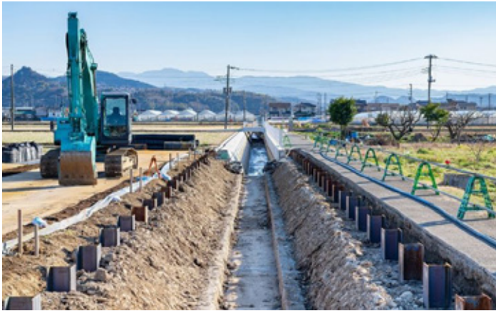
FIGURA 21 – CONSTRUÇÃO DE UM CANAL AGRÍCOLA
