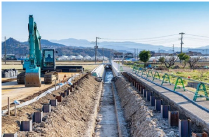
FIGURA 4 – CONSTRUÇÃO DE UM CANAL AGRÍCOLA
